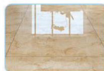
Suelos de baldosas
